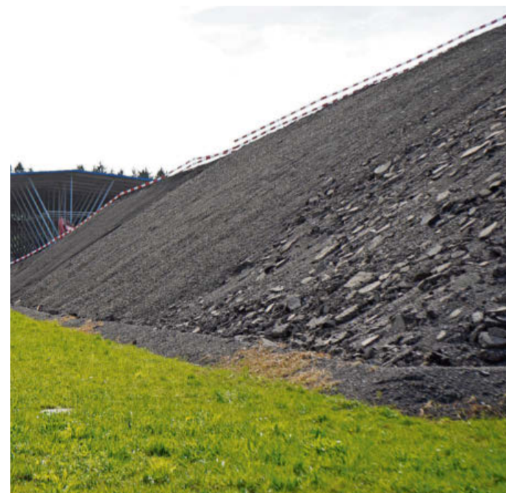
Ausbauasphalt auf dem Gelände der FBB in Hinwil. Das Material darf nur teilweise rezykliert werden. Der Kanton Zürich ist hier strenger als der Rest der Schweiz.
